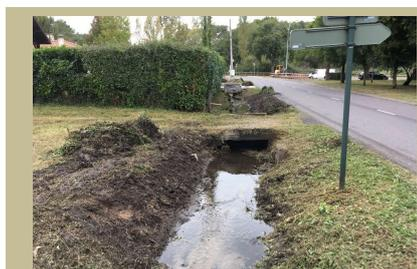
Travaux mécaniques d'arrachage de jussie réalisés par la commune de Seignosse en amont du périmètre en RN, sur le ruisseau de Fontaine de Sable
